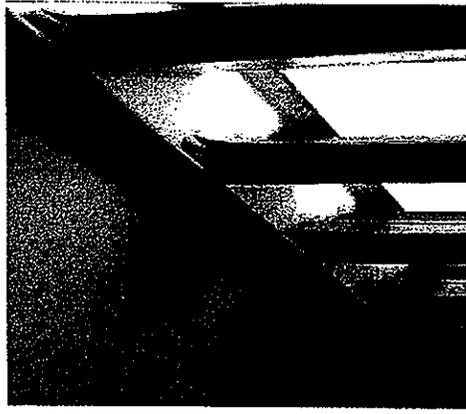
Foto 11. Desprendimiento de gradas de goma en escalas de acceso a nivel 4,20.
